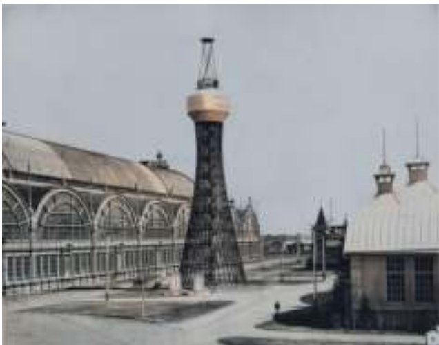
Башня Шухова на Всероссийской выставке в Нижнем Новгороде (первая в мире гиперболюидная конструкция). Фотография М. П. Дмитриева, 1896 г.
