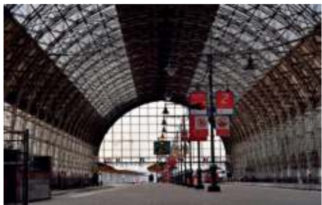
Дебаркадер Киевского вокзала, г. Москва
